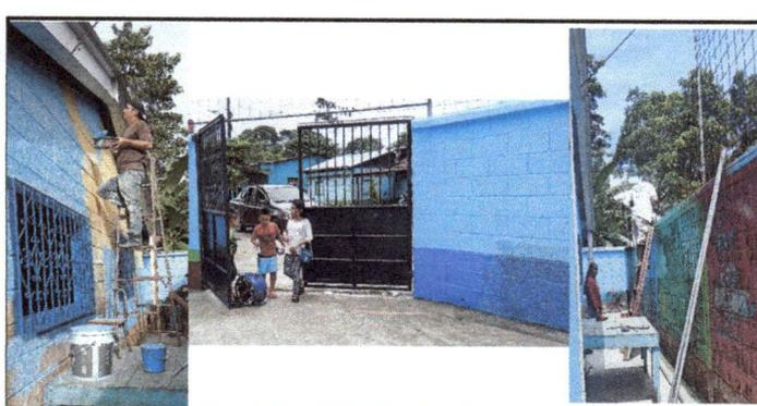
Foto 6: mantenimiento de pintura en muros interiores y exteriores, mantenimiento de balcones, portón y malla de muro perimetral
